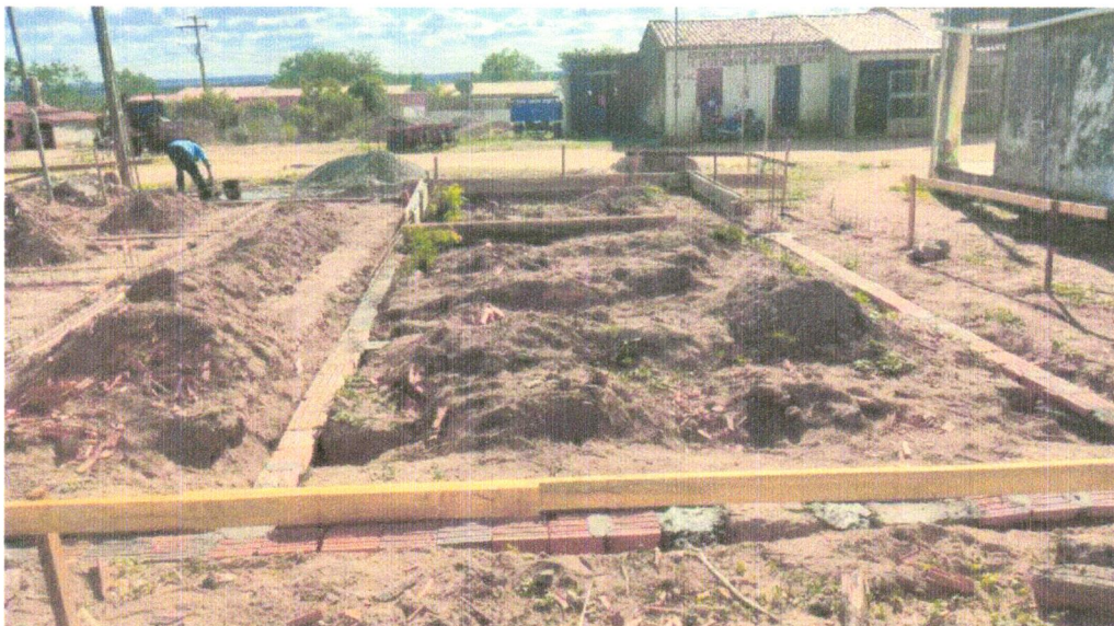
Foto 18- LOCACAO CONVENCIONAL DE OBRA, UTILIZANDO GABARITO DE TÁBUAS CORRIDAS PONTALETADAS
