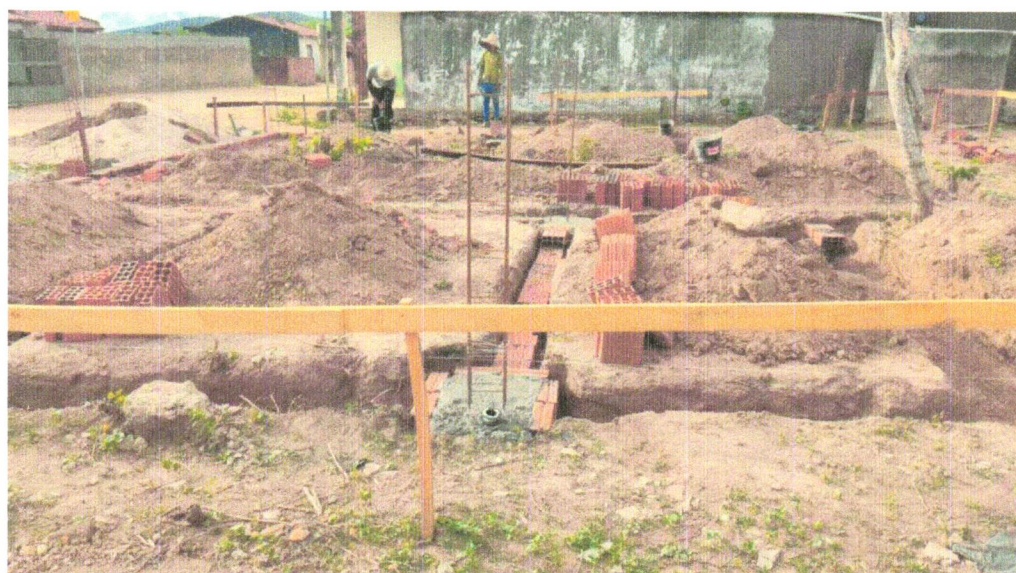
Foto 14- LOCAÇÃO CONVENCIONAL DE OBRA, UTILIZANDO GABARITO DE TÁBUAS CORRIDAS PONTALETADAS
