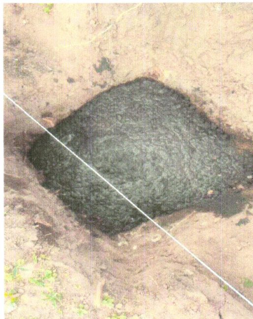
FOTO 12- LASTRO DE CONCRETO MAGRO, APLICADO EM BLOCOS DE COROAMENTO OU SAPATAS, ESPESSURA DE 3 CM
