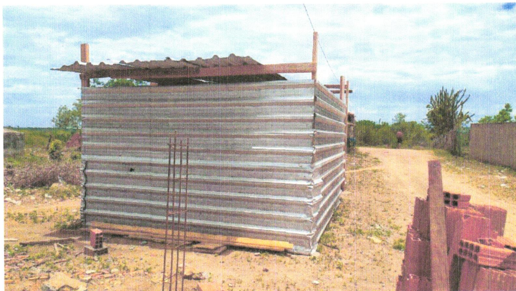
FOTO 02 – Barracão para Obras de Médio Porte Reaproveitamento 2 vezes
