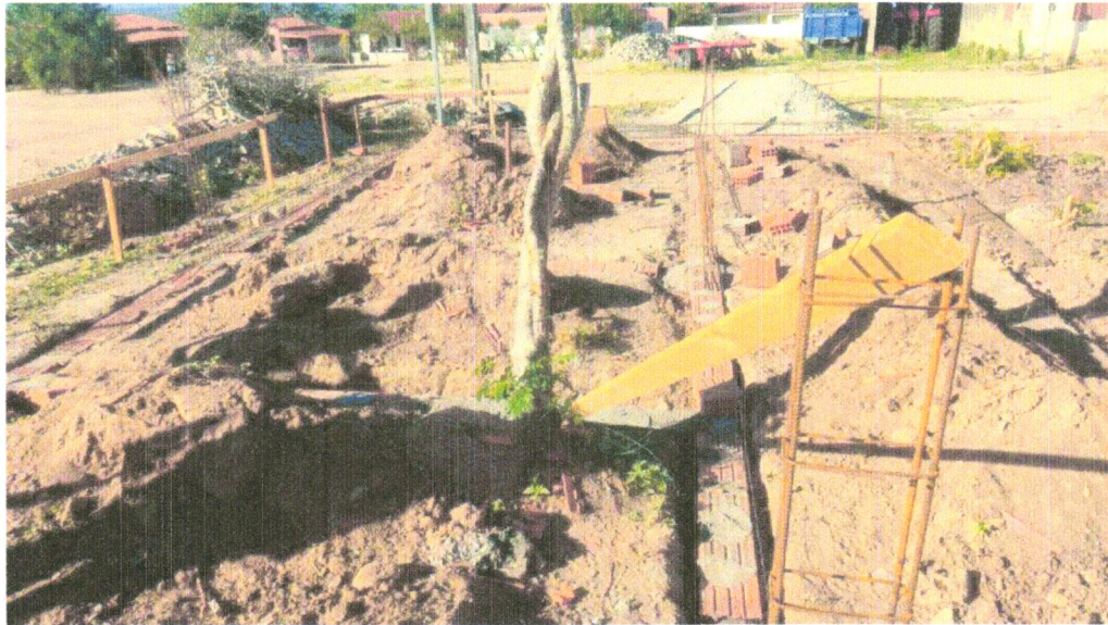
FOTO 11 – LASTRO DE CONCRETO MAGRO, APLICADO EM BLOCOS DE COROAMENTO OU SAPATAS, ESPESSURA DE 3 CM
