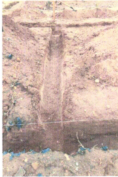
Foto 07 – ESCAVAÇÃO MANUAL DE VALA PARA VIGA BALDRAME (INCLUINDO ESCAVAÇÃO PARA COLOCAÇÃO DE FÔRMAS). AF_06/2017
