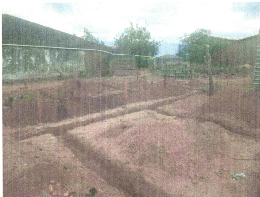
FOTO 05 – ESCAVAÇÃO MANUAL DE VALA PARA VIGA BALDRAME (INCLUINDO ESCAVAÇÃO PARA COLOCAÇÃO DE FÔRMAS). AF_06/2017
