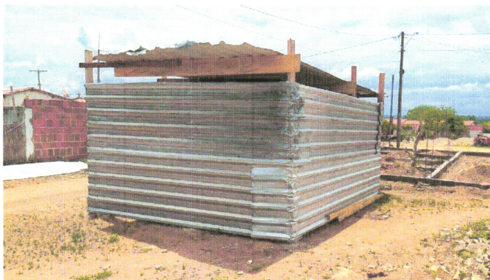
FOTO 03 - Barracão para Obras de Médio Porte Reaproveitamento 2 vezes
