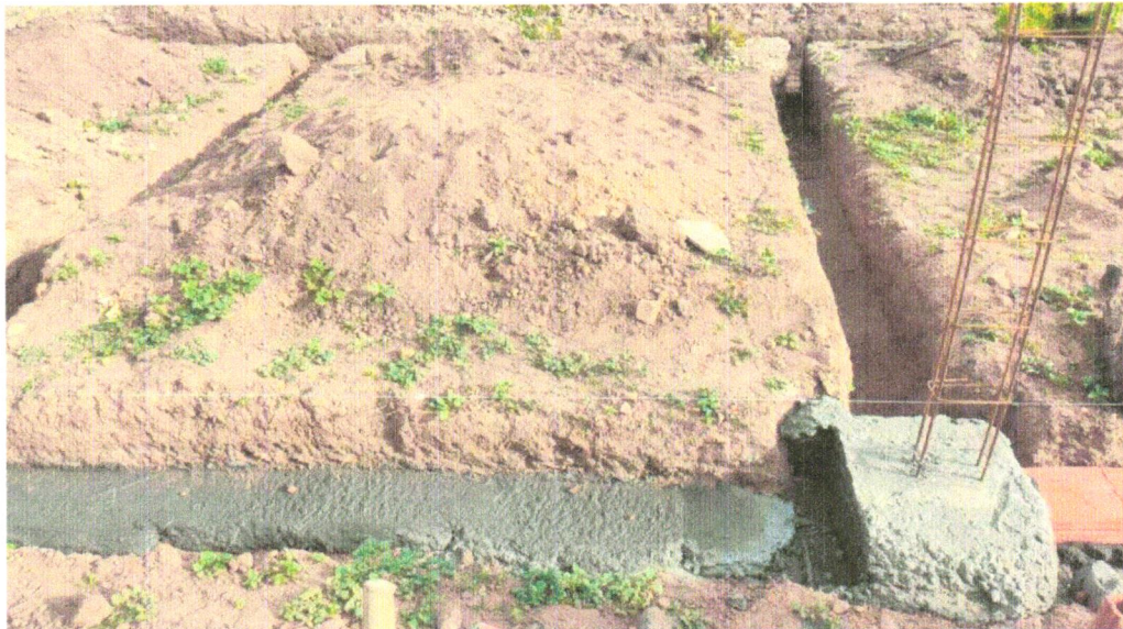
FOTO 08 - LASTRO DE CONCRETO MAGRO, APLICADO EM BLOCOS DE COROAMENTO OU SAPATAS, ESPESSURA DE 3 CM
