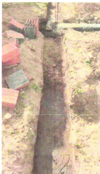
FOTO 09 – ESCAVAÇÃO MANUAL DE VALA PARA VIGA BALDRAME (INCLUINDO ESCAVAÇÃO PARA COLOCAÇÃO DE FÔRMAS). AF_06/2017
