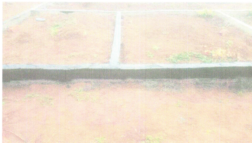
Foto 24 - IMPERMEABILIZAÇÃO DE SUPERFÍCIE COM EMULSÃO ASFÁLTICA, 2 DEMÃOS
