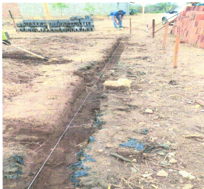
FOTO 04 - ESCAVAÇÃO MANUAL DE VALA PARA VIGA BALDRAME (INCLUINDO ESCAVAÇÃO PARA COLOCAÇÃO DE FÔRMAS). AF_06/2017
