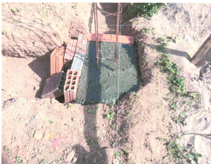
FOTO 13- COMPOSIÇÃO REPRESENTATIVA) EXECUÇÃO DE ESTRUTURAS DE CONCRETO ARMADO, PARA EDIFICAÇÃO HABITACIONAL UNIFAMILIAR TÉRREA (CASA EM EMPREENDIMENTOS), FCK = 25 MPA. AF_01/2017
