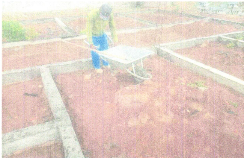
Foto 23 - ATERRO MANUAL DE VALAS COM AREIA PARA ATERRO E COMPACTAÇÃO MECANIZADA. AF
