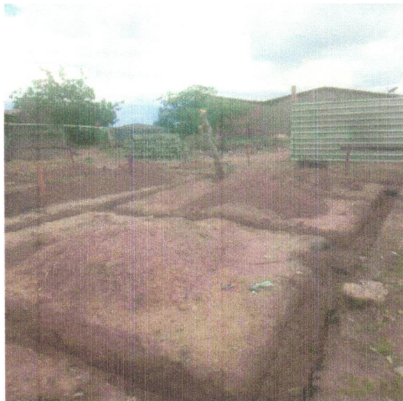
FOTO 05 – ESCAVAÇÃO MANUAL DE VALA PARA VIGA BALDRAME (INCLUINDO ESCAVAÇÃO PARA COLOCAÇÃO DE FÔRMAS). AF_06/2017
