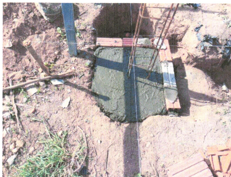
Foto 16 - COMPOSIÇÃO REPRESENTATIVA) EXECUÇÃO DE ESTRUTURAS DE CONCRETO ARMADO, PARA EDIFICAÇÃO HABITACIONAL UNIFAMILIAR TÉRREA (CASA EM EMPREENDIMENTOS), FCK = 25 MPA. AF_01/2017
