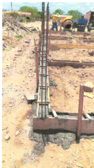
Foto 20 - COMPOSIÇÃO REPRESENTATIVA) EXECUÇÃO DE ESTRUTURAS DE CONCRETO ARMADO, PARA EDIFICAÇÃO HABITACIONAL UNIFAMILIAR TÉRREA (CASA EM EMPREENDIMENTOS), FCK = 25 MPA. AF_01/2017
